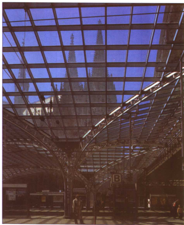
图 3-2a 金属框架结构的德国科隆火车站候车处
