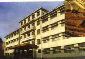
每个县都建设了农技推广中心 图为沁县农技中心大楼
