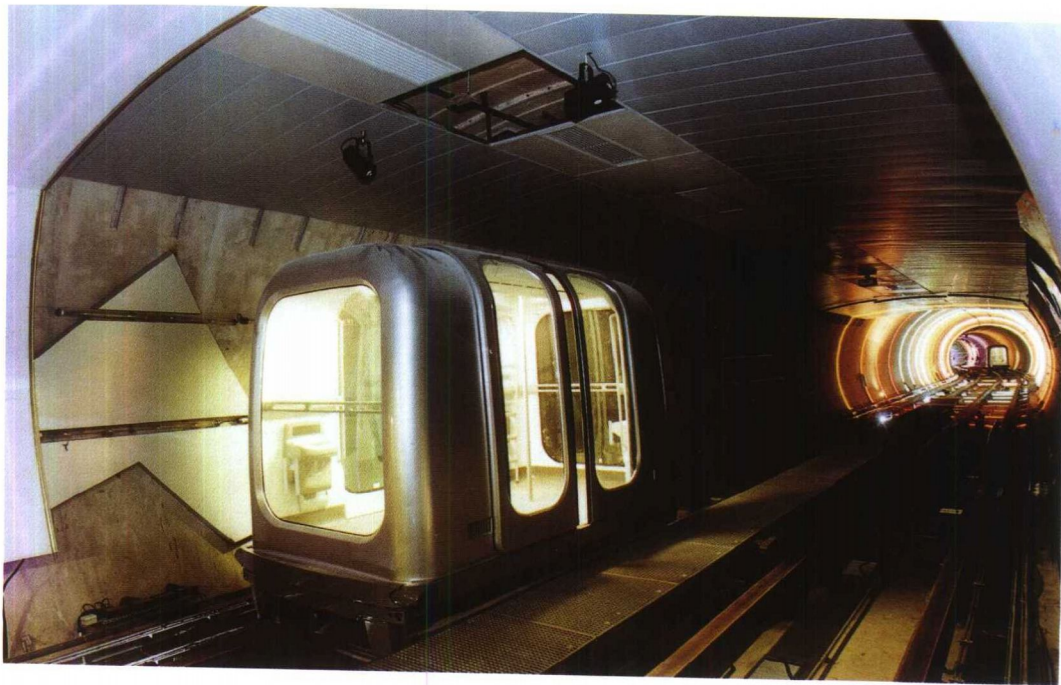
外滩观光隧道内景(施工中)
