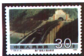
▲ 衡广复线大瑶山隧道 (1989年)
