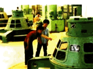
永寿石桥水电站
