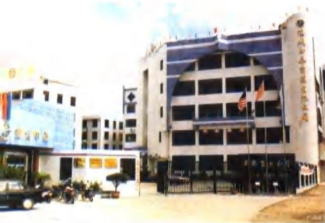
正泰集团公司总部行政办公大楼
