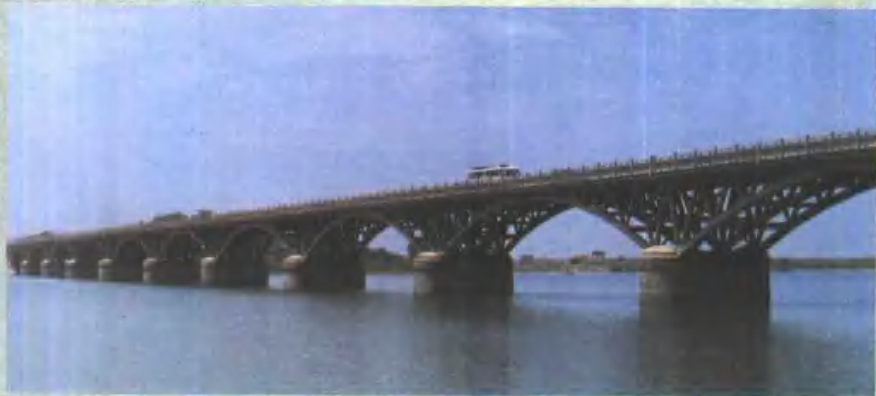
贵池市杜坞大桥
