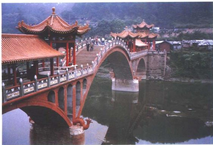
照片20 四川乐山濠上大桥
