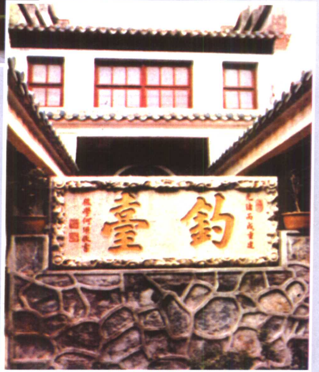
▲ 江门陈白沙钓台故址 (江门市国土局提供)
