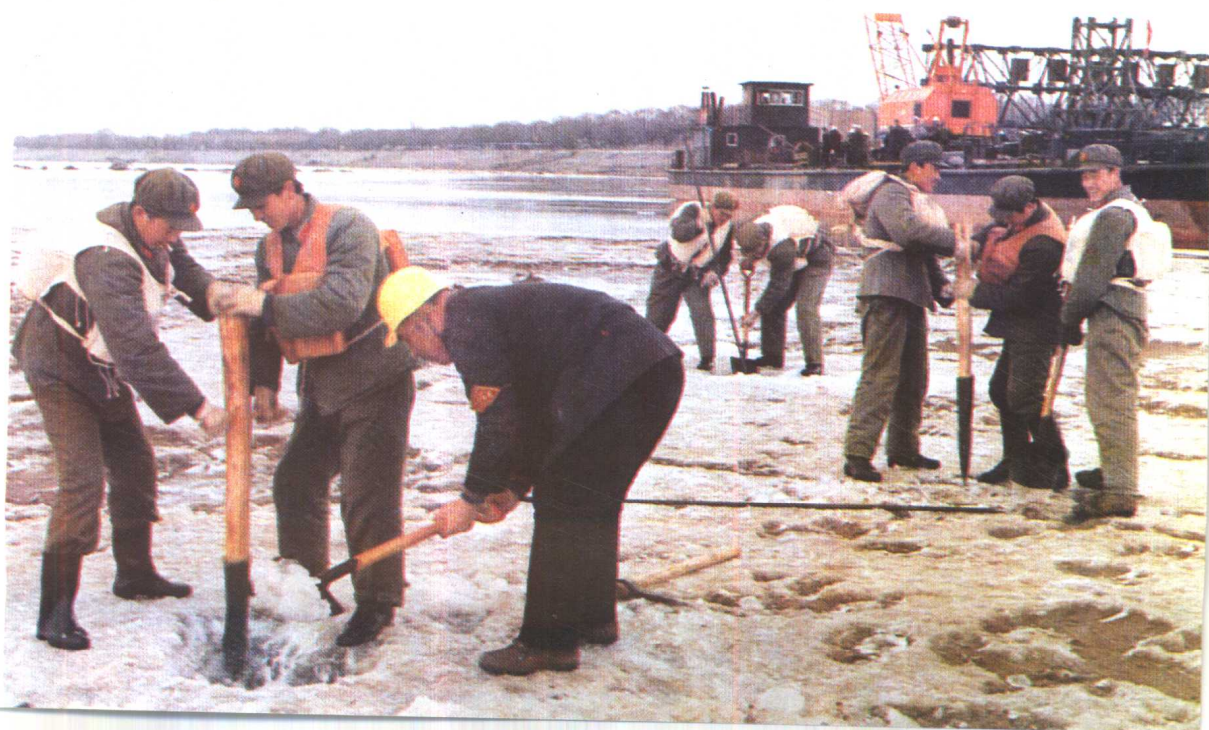
1984年4月， 解放军某部工 兵营为哈尔滨 公路大桥施工 安全破冰排险
