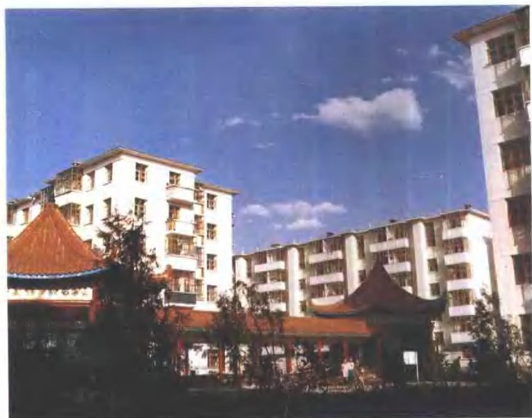
居民住宅小区一角
