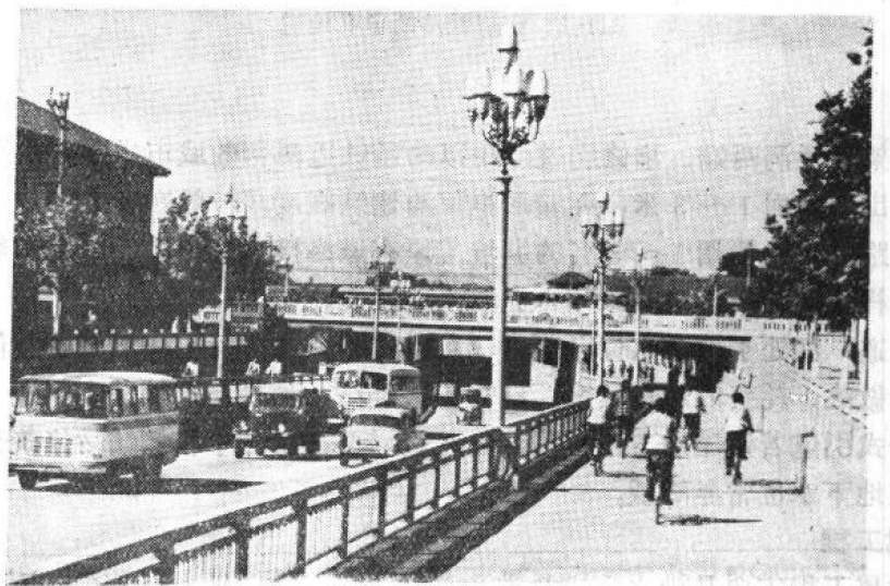
图1-1 已建成的某市穿越铁路的地道
