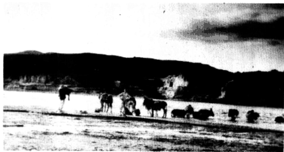
甘谷姚庄大桥冲毁后群众 过河难的情况（民国三十八年）
