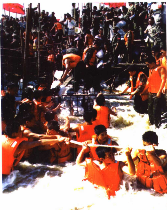
南京军区部队官兵，在洪水中搭铁架，填土石，封堵九江决口。
