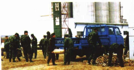
驻晋某部官兵积极支援国家“八五”重点项目山西省水泥厂工程。
