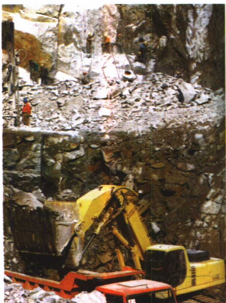
武警水电部队打响举世瞩目的三峡工程第一炮，承担了永久船闸的施工任务。
