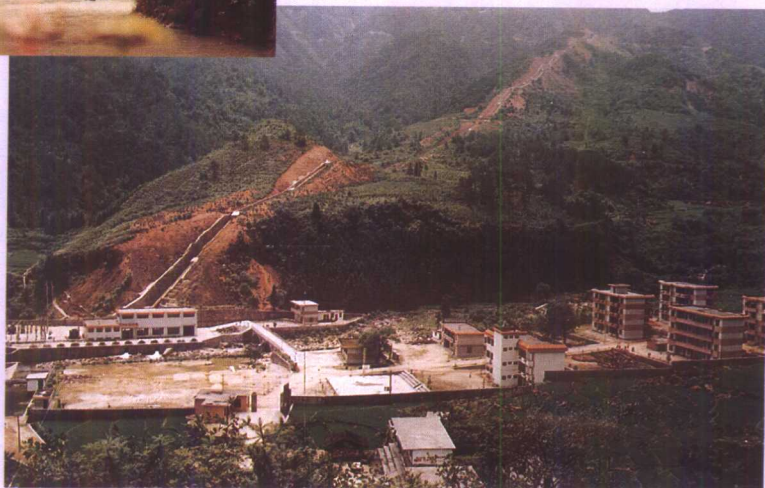
连南板洞水库 ▶ 第一级发电站
