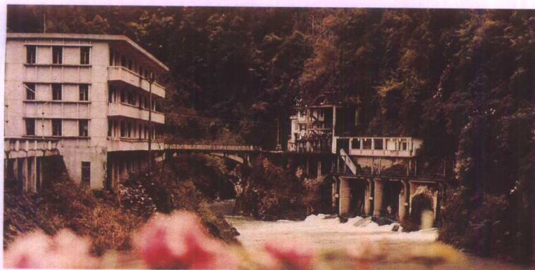
◀ 乳源泉水水电站
