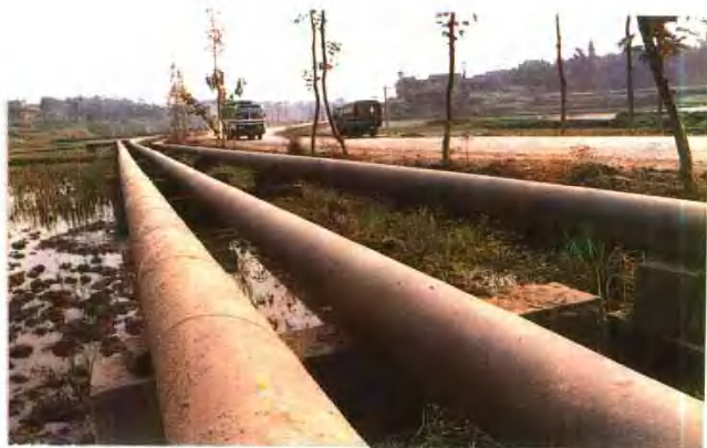
◀ 31. 自贡盐场场内管道
