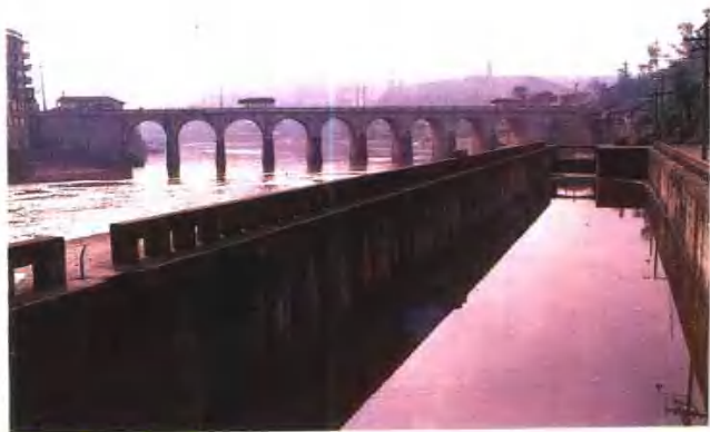
► 28. 釜溪河邓关船闸及邓关大桥
