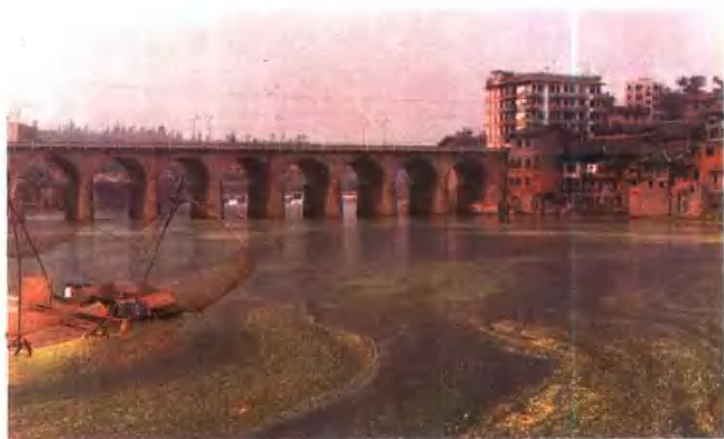
◀ 19. 改建后的邓关大桥
