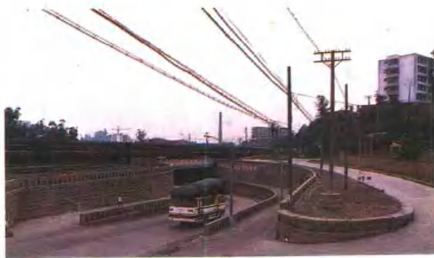
► 6. 三八公路铁路立交桥
