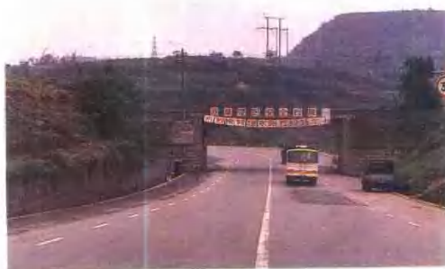
► 8. 回东公路铁路立交桥
