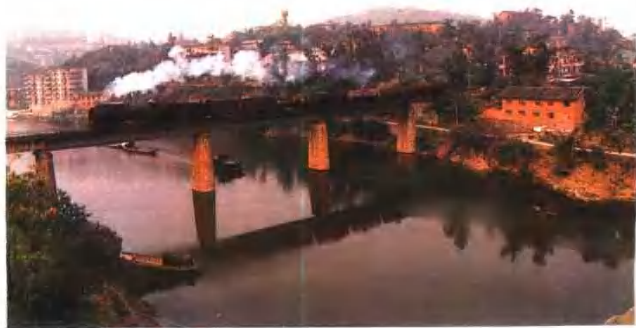
► 20. 东兴寺金溪河立交桥
