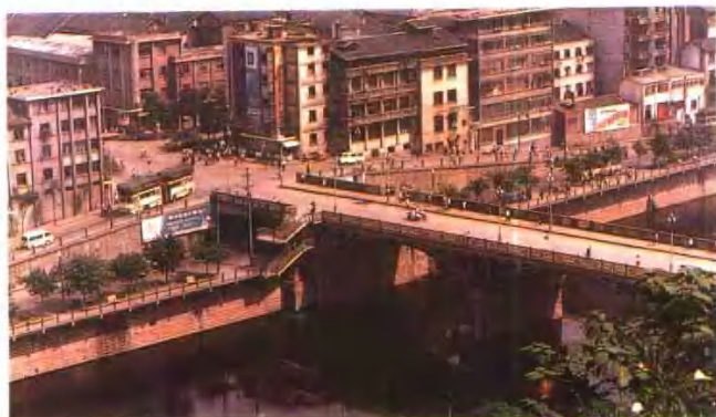
◀ 7. 十字路口金溪河立交桥
