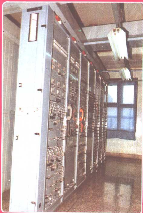
△中同轴 4380 路载波通信系统(邮电部第五研究所研制,获国家科技进步一等奖、邮电部科技进步一等奖)
