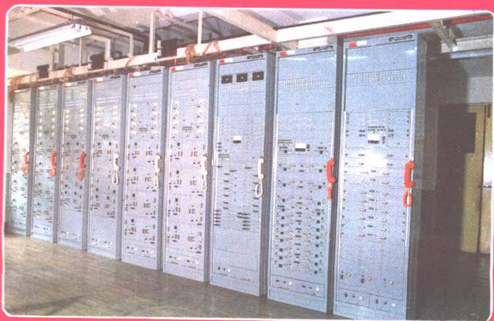
▽小同轴电缆 300 路载波通信系统 (眉山通信设备厂研制,获邮电部科技进步一等奖)
