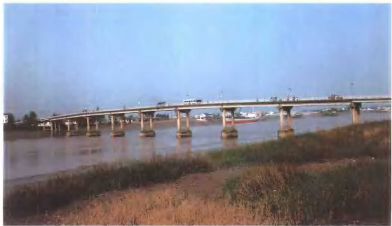
鳌江龙港大桥
