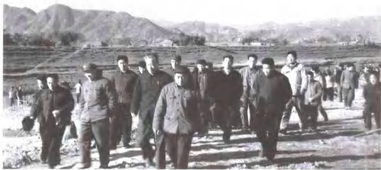
地、县委领导视察横阳支江疏浚工程。
