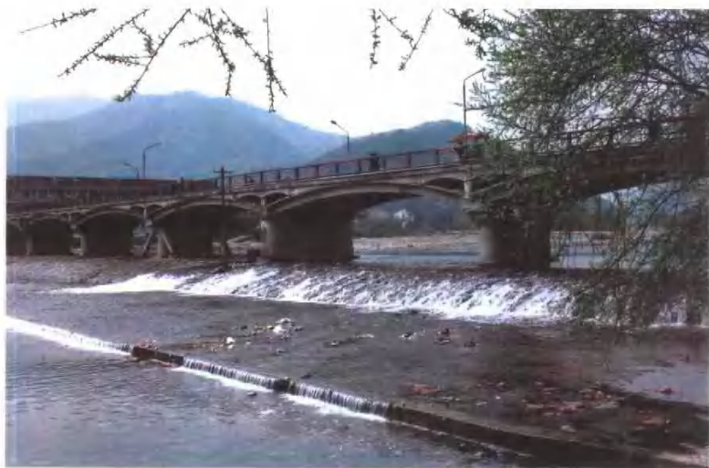
山门引水工程
