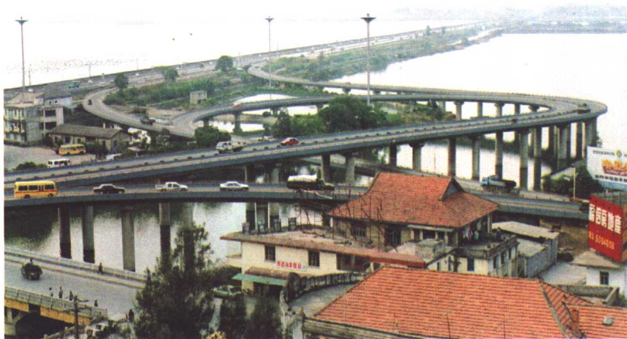
厦门集美立交桥
