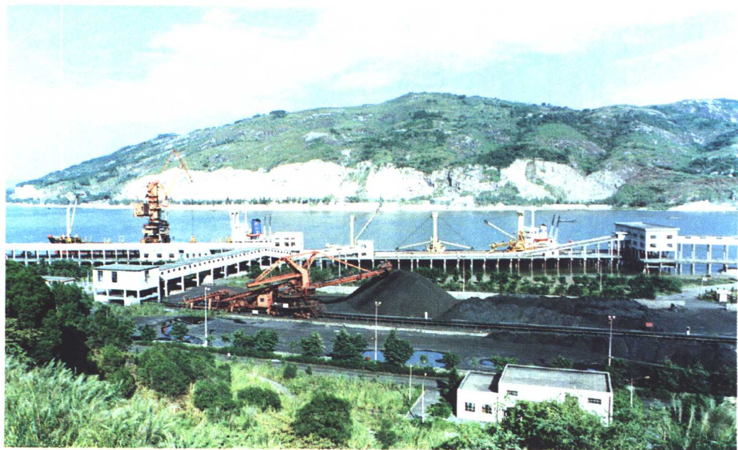
福州港松门港区煤码头
