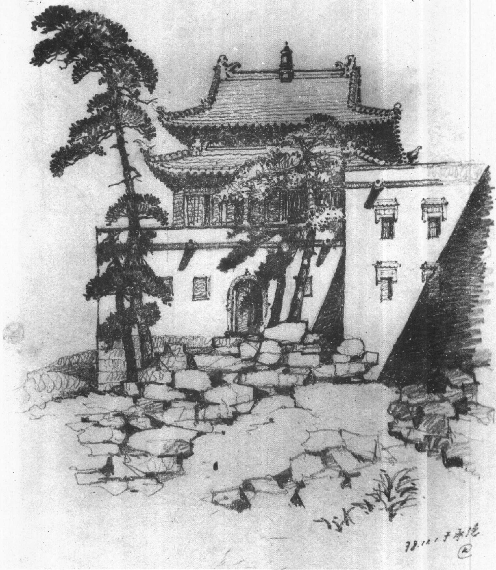
承德外八庙吉祥法喜殿
