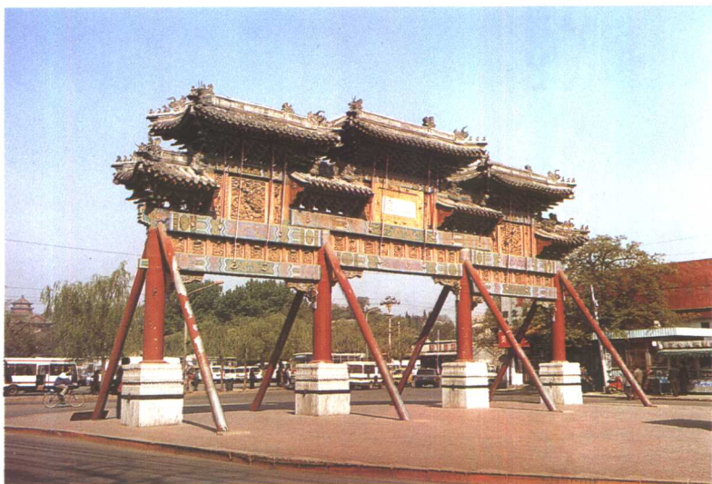
颐和园东宫门牌楼
