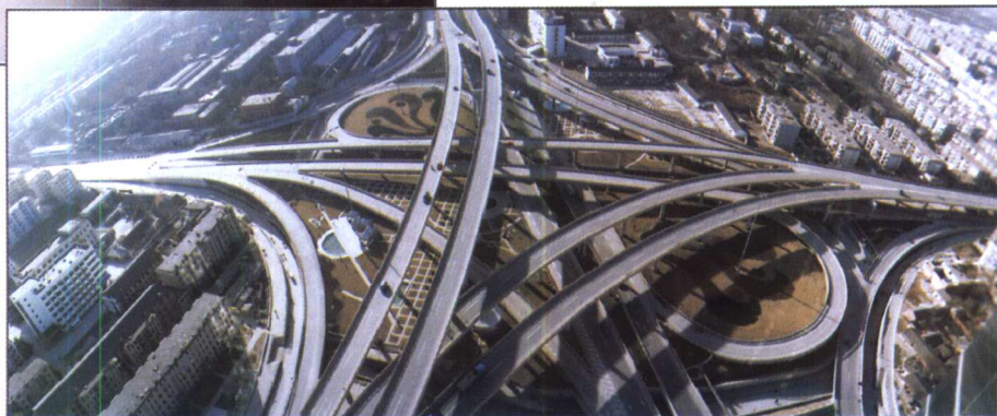
合肥五里墩立交桥
