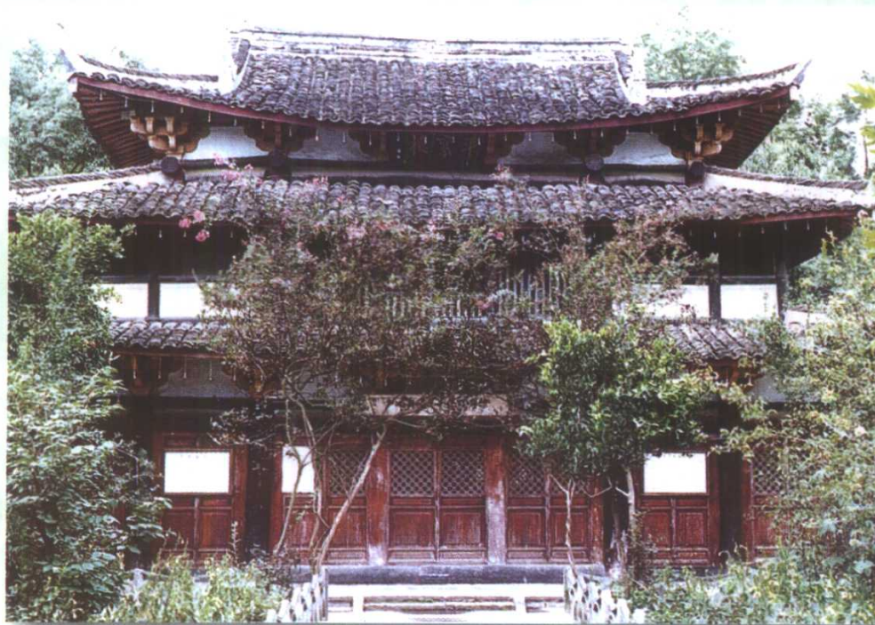
古建筑平襄楼
