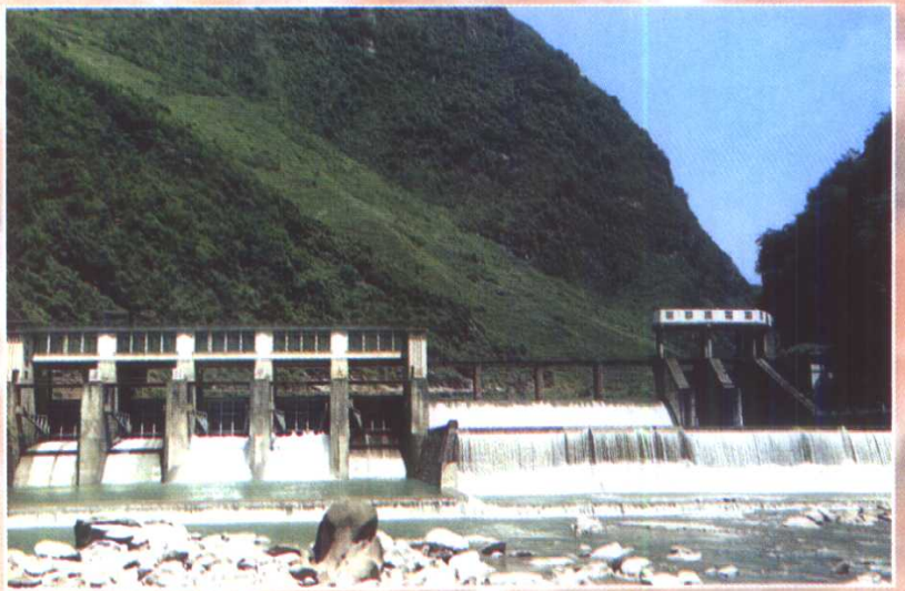
位于金鸡峡的玉溪河引水灌溉工程大坝
