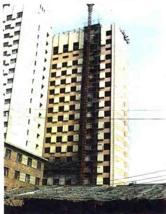
◀ 正在建设中的迎宾馆饭店南楼
