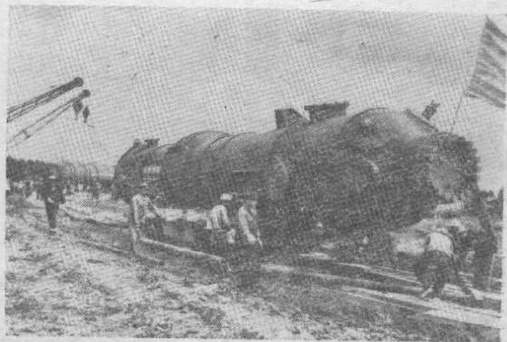
大庆工人把几百吨重的大型设备，用人拉手推的办法运到现场
