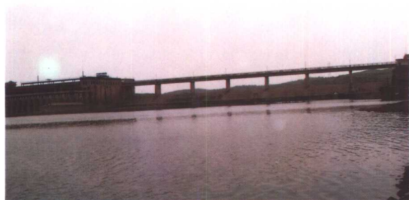
▲ 白渔潭水电站
