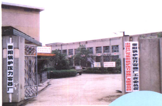
▲ 锅炉压力容器厂
