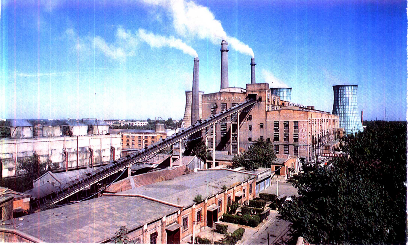
▲ 商丘电厂(厂区一隅)
