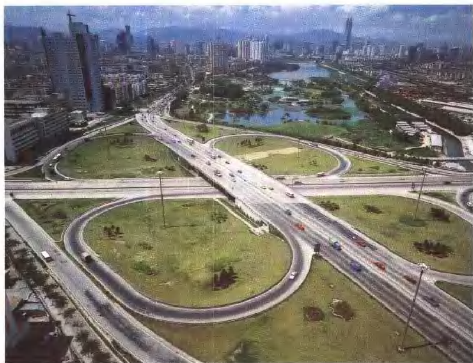
畅顺的城市道路系统
