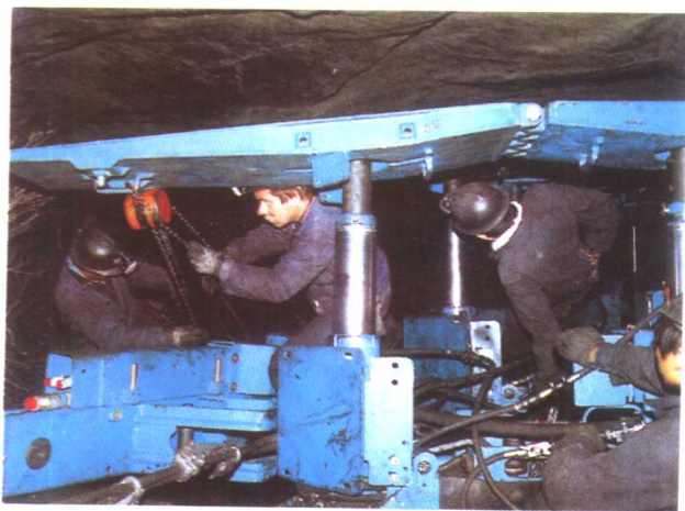
从西班牙引进急倾斜综采机组安装调试
