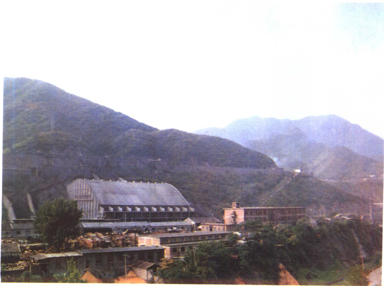
不城洞煤矿加盖煤仓
