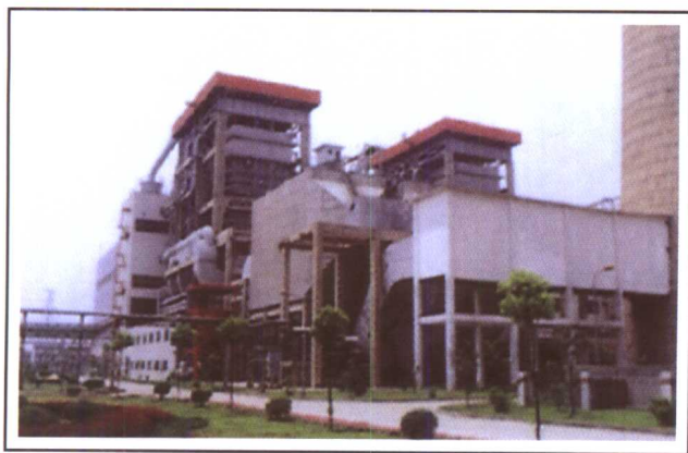
上海威钢高炉煤气发电工程(环保节能型)
