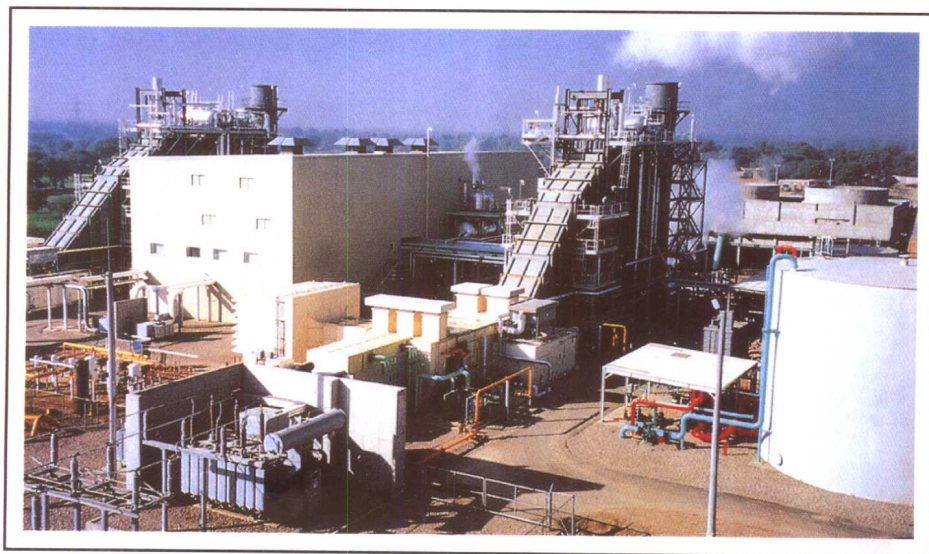
巴基斯坦 KAIRWALA 燃气蒸汽联合循环电站
