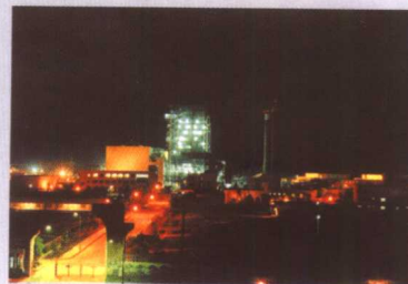
CMEC 承建的孟加拉吉大港 21 万 kW 火电站夜景
