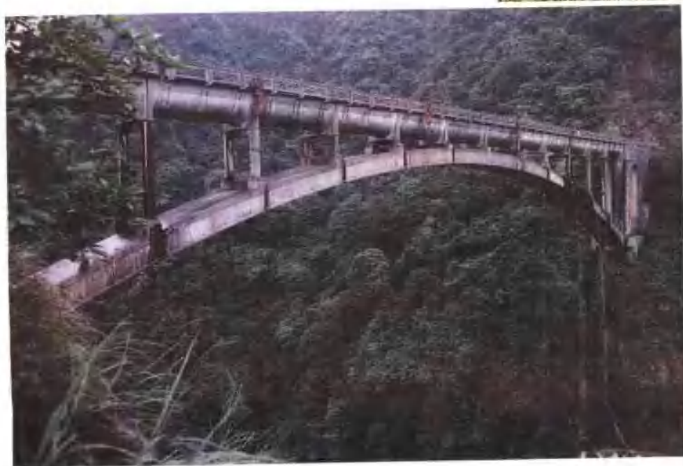
△ 郴县高峰水库渡槽
