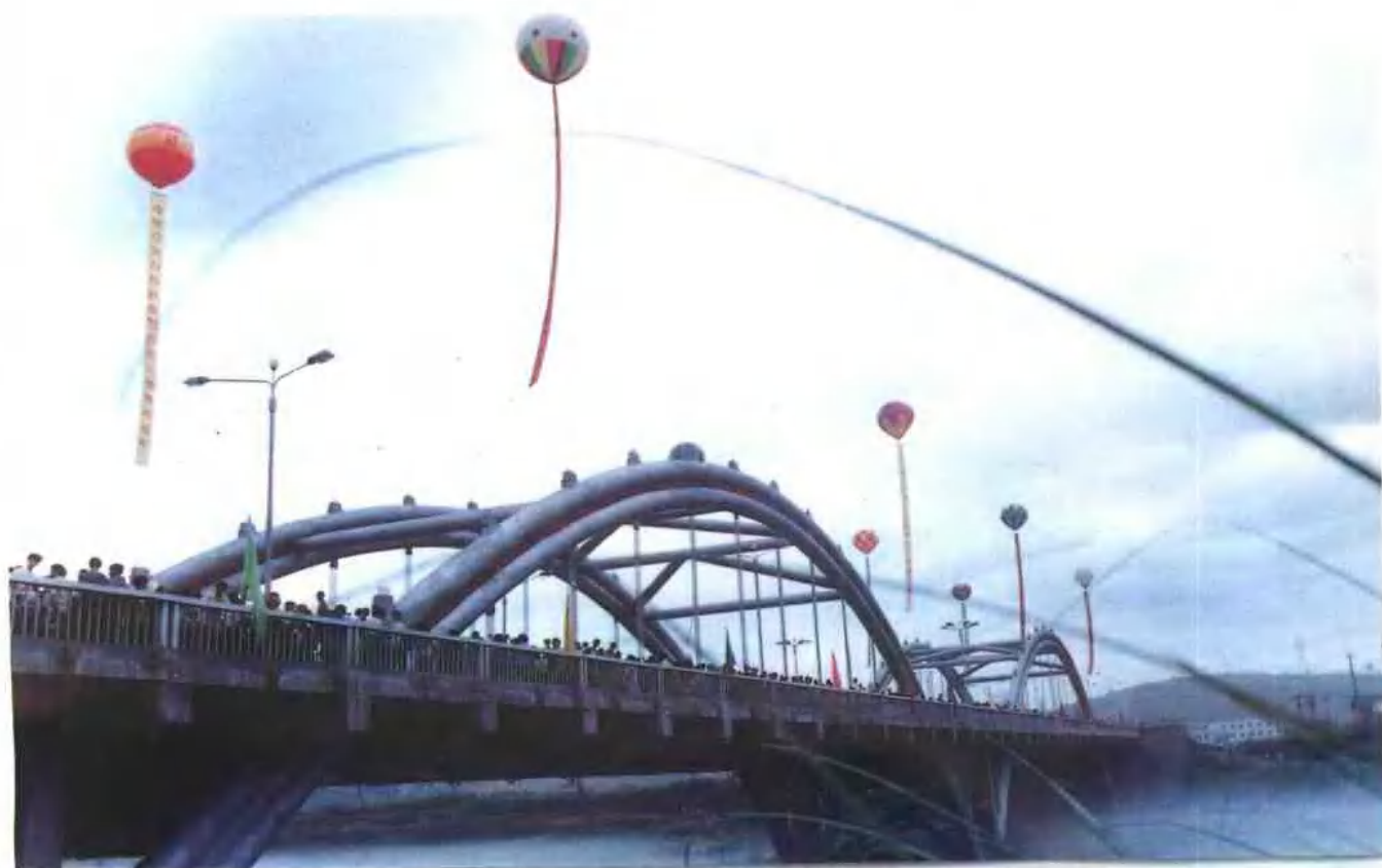
▽ 资兴鲤鱼江公路大桥
