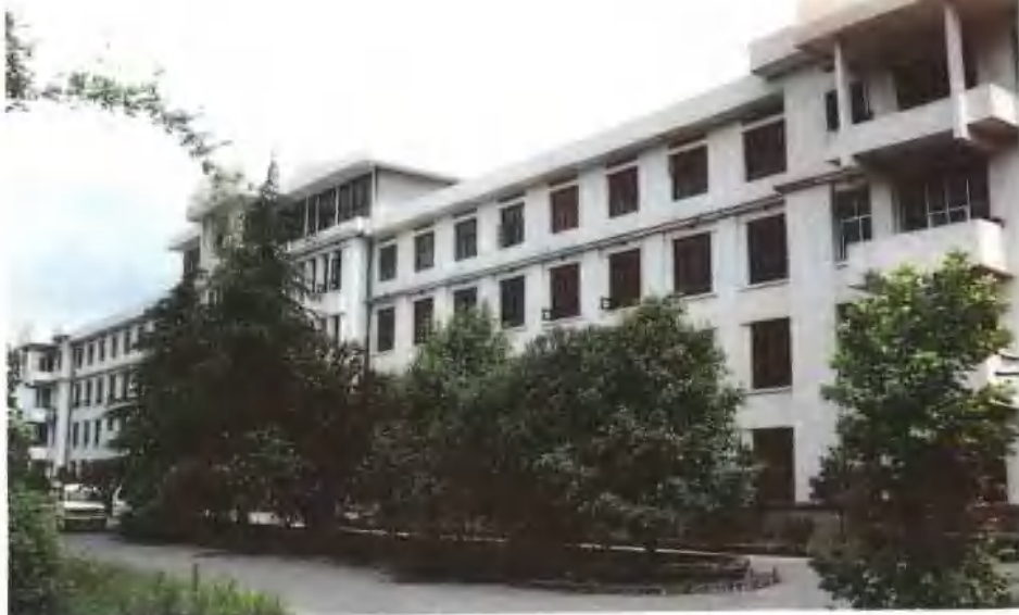
▷ 中共郴州地委 办公大楼
