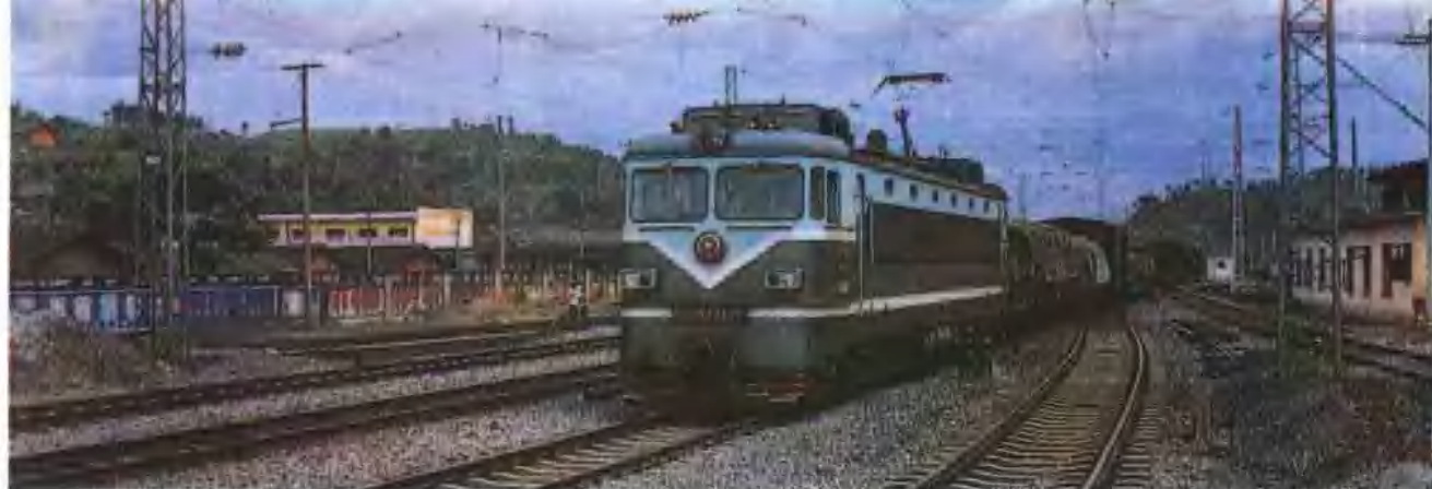
△ 京广线郴（州）韶（关）段电气化铁路
