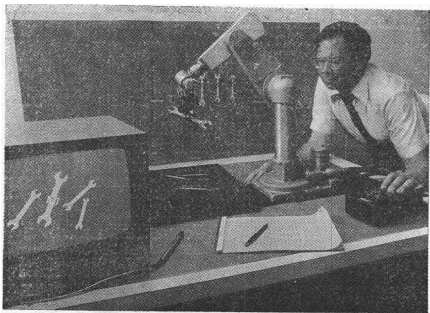
圖 1-5 機器智慧公司的傑利·格里遜先生正在研究機器人的三度空間視覺系統 (Rick Browne-High Technology)
