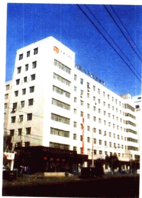
△中国人民保险公司本溪分公司办公楼
