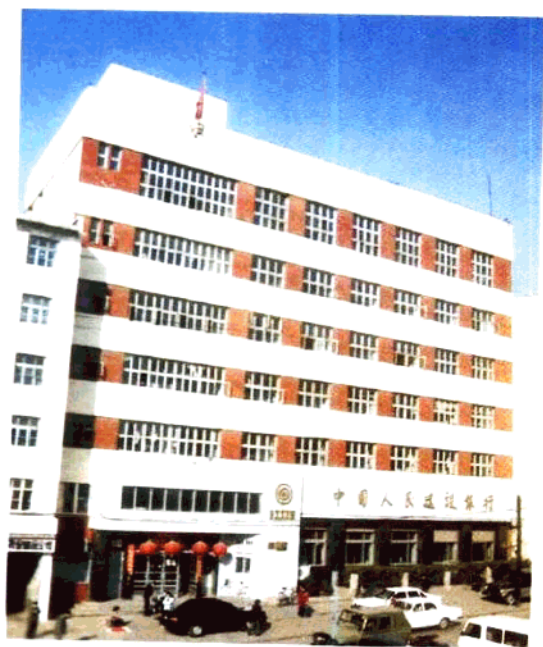
△中国人民建设银行本溪市分行办公楼
