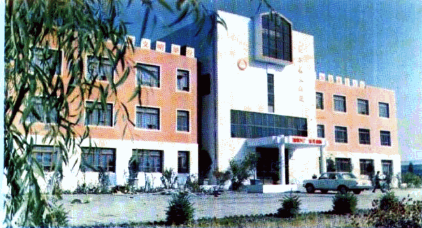
▷庆安县水泥厂办公楼
