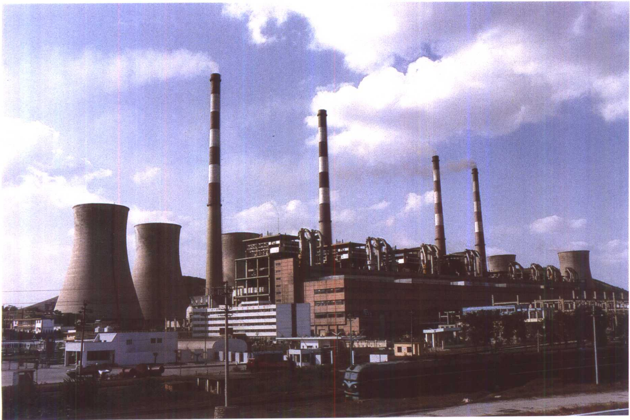
△ 江苏省最大的坑口电厂—徐州发电厂
