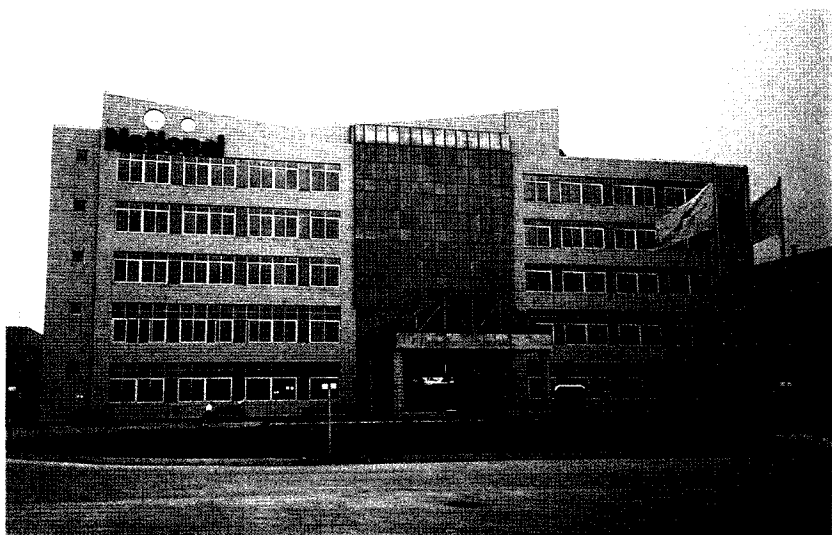
松下万宝(广州)空调器有限公司和松下万宝(广州)压缩机有限公司是松下电器在华南投资的两家重要企业。图为这两家企业的主楼。(王志乐摄)
