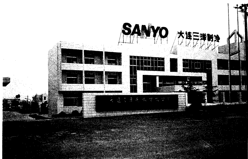
三洋电机与大连冷冻机股份公司合资建立的大连三洋制冷有限公司生产大型吸收式制冷机。技术先进，产品畅销，经营良好。(王志乐摄)
