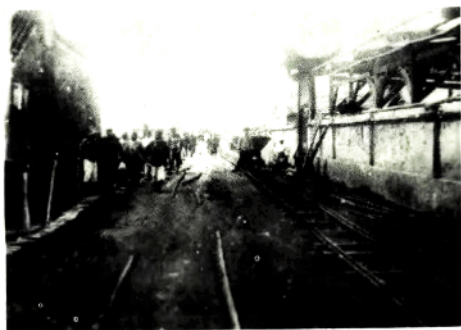
道路工程施工中用于筑路运输的轻便铁路
