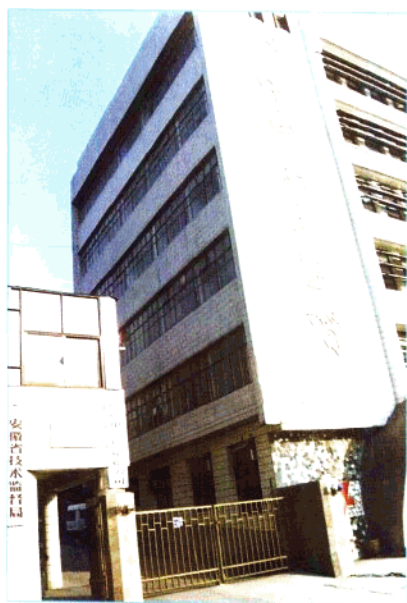
安徽省技术监督局办公大楼一角
