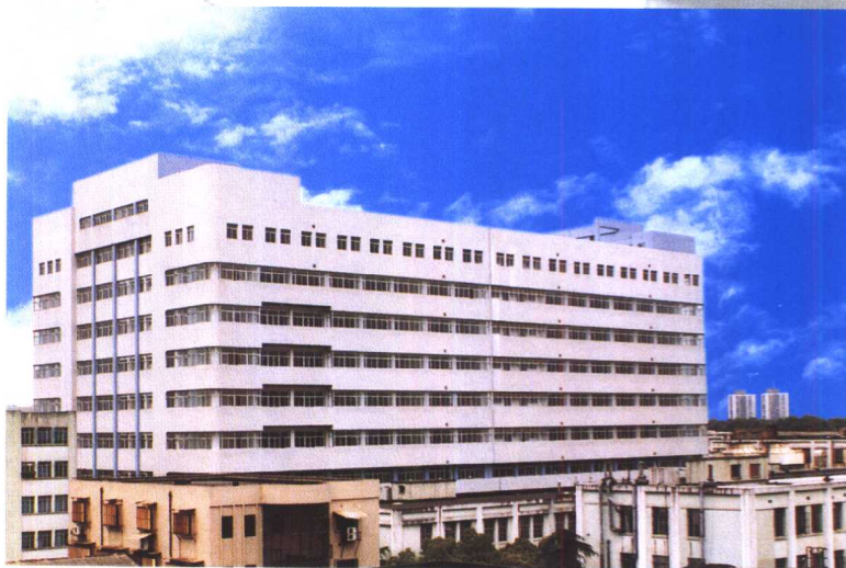
国家级移动卫星通信技术工程研究中心于1996年建成,确保产品始终跟踪国际先进水平
