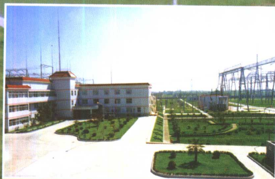
500 千伏的东善桥变电站主控楼
