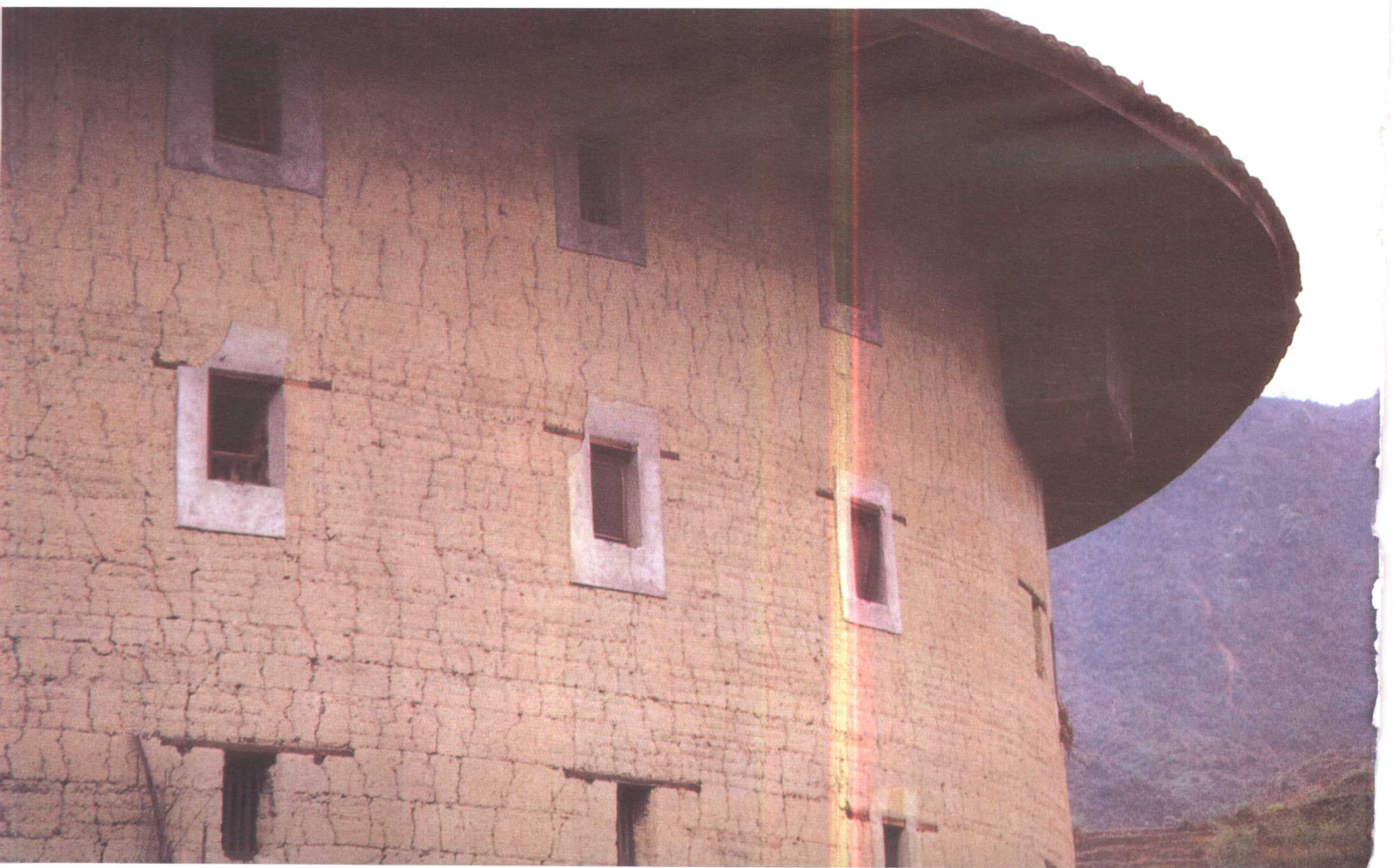
環形土樓外壁（懷遠樓）
