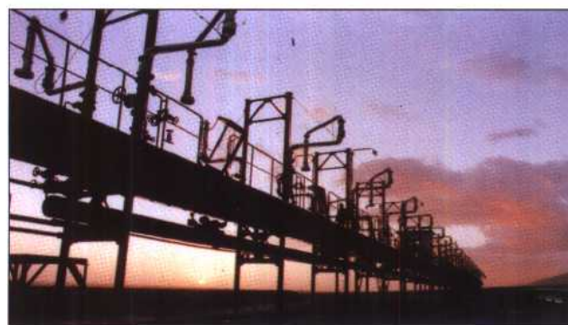
轮台—库尔勒输油管道火车装油台
