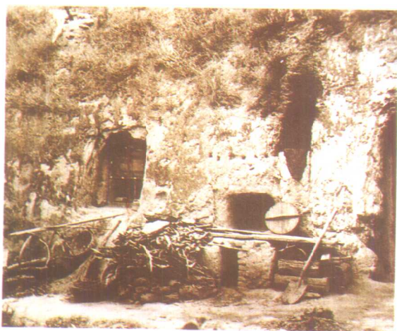
旧中国阳泉煤矿工人居住的土穴
