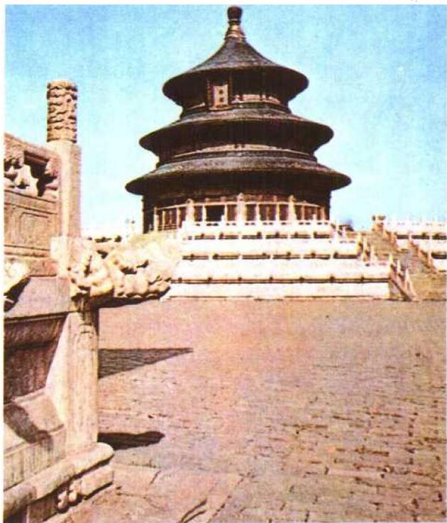
中。这些模型描绘了一种建筑形式——瓦顶单层或两层建筑,中央空间巨大,角上有塔形装饰。到此发展阶段,中国建筑艺术的基本特点已见端倪。与西方建筑不同,中国建筑不采用柱楣系统,而使用屋顶和圆柱结构。圆柱之间的空间用轻质墙填充。支柱上横跨突出的栋梁,梁的截面通常为方形,栋梁再支撑十字形托架。正是这种结构使得屋顶的下部向上弯曲伸展这个特征成为可能。
