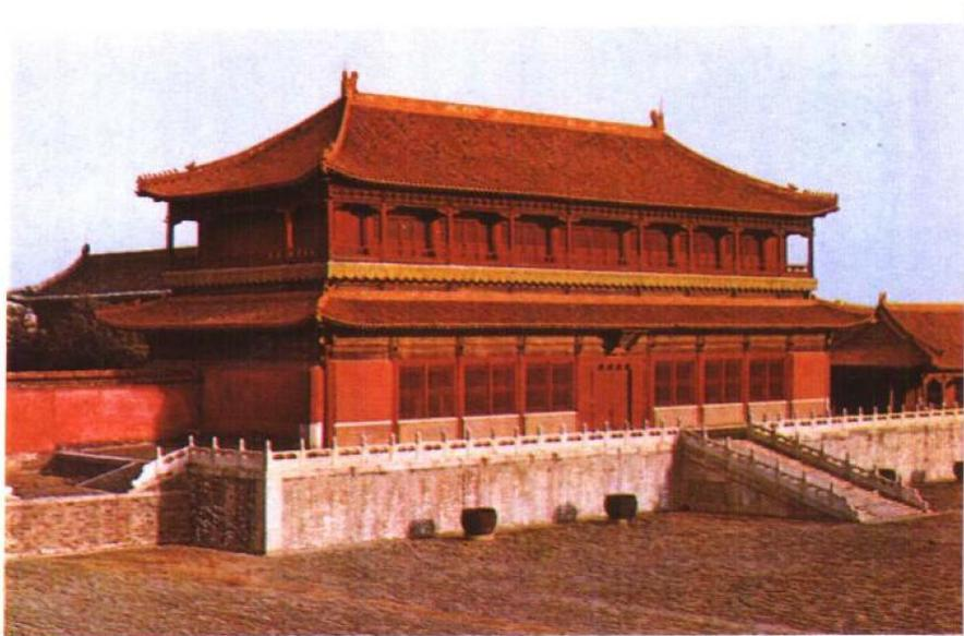
▲ 紫禁城中的另一座建筑——体仁阁也以陡峭的双层屋顶为特征，各层屋顶均建在柱廊上。柱为木制，而且各层的高度取决于所能采用的木材的长度。
