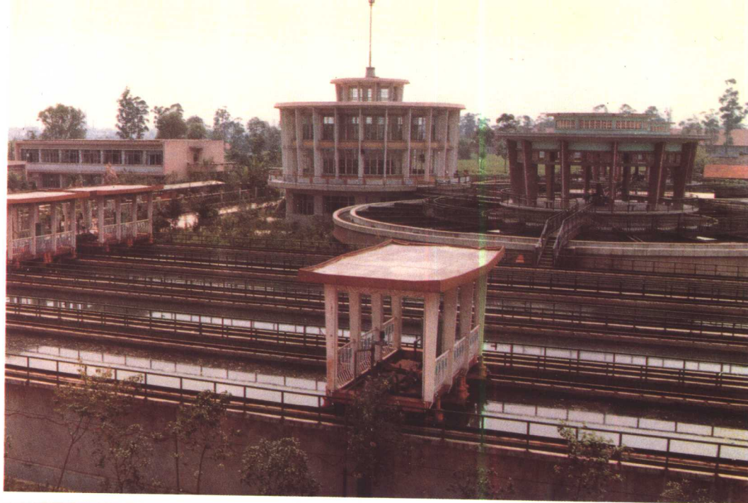
自来水五厂加速沉清池
