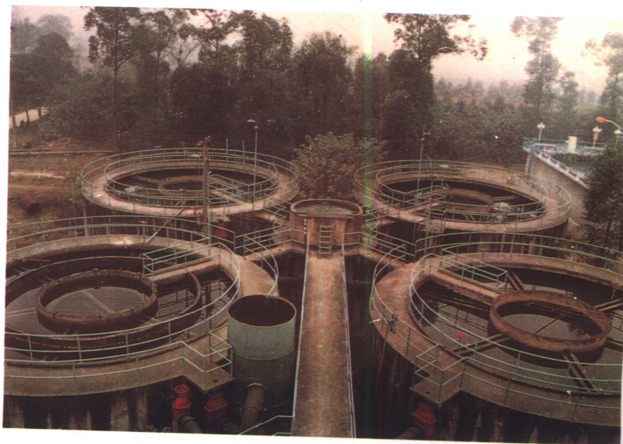
自来水二厂悬浮沉清池
