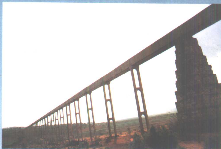
引水渡槽 (董石玉 摄)
