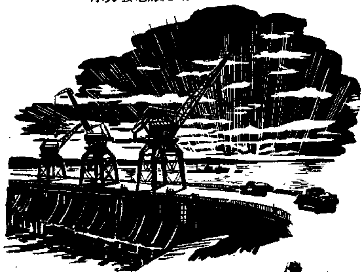
水力發電廠建築
