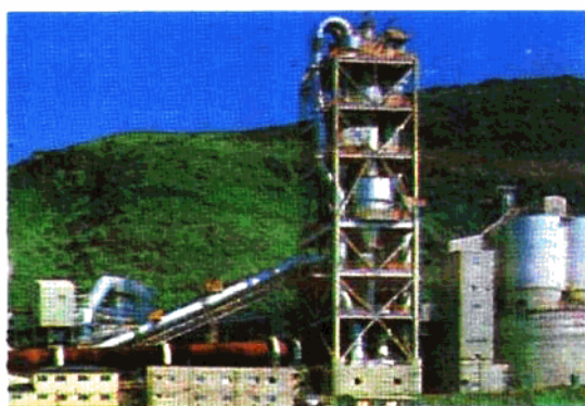
▲ 朝阳重型机器厂， 日产500、800、 1000吨水泥熟料 成套设备
