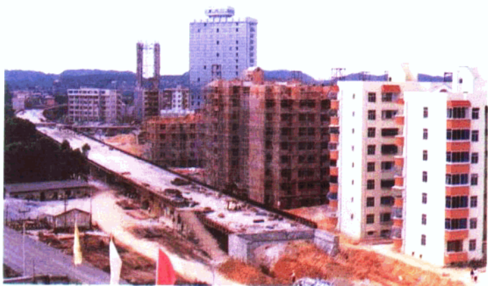
施工中的邕江三桥北岸引桥
