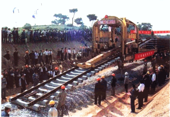
南昆铁路东段铺轨仪式
