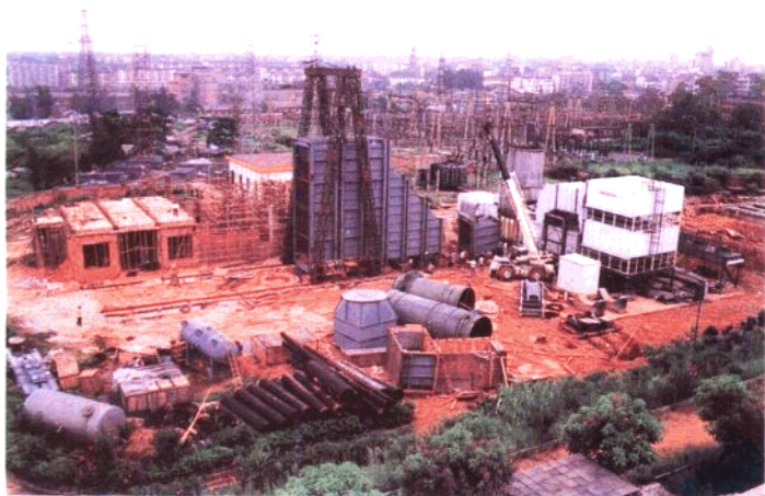
南宁燃气轮机发电有限公司增容1.5万千瓦 二期工程在进行设备安装。
