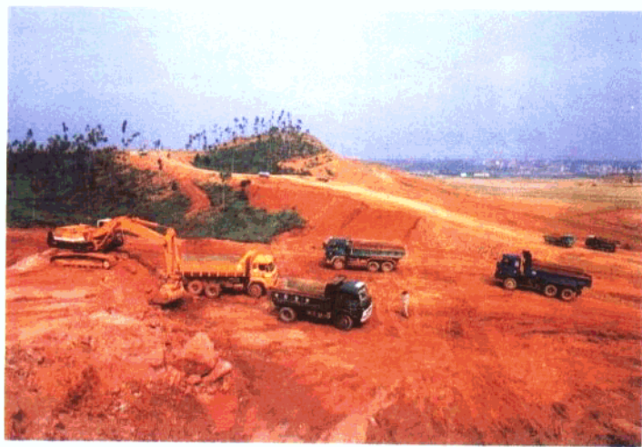
建设中的南宁市经济技术开发区“三通一平”工程。周家志 摄
