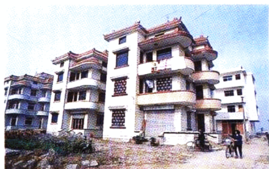
村民新建住宅
