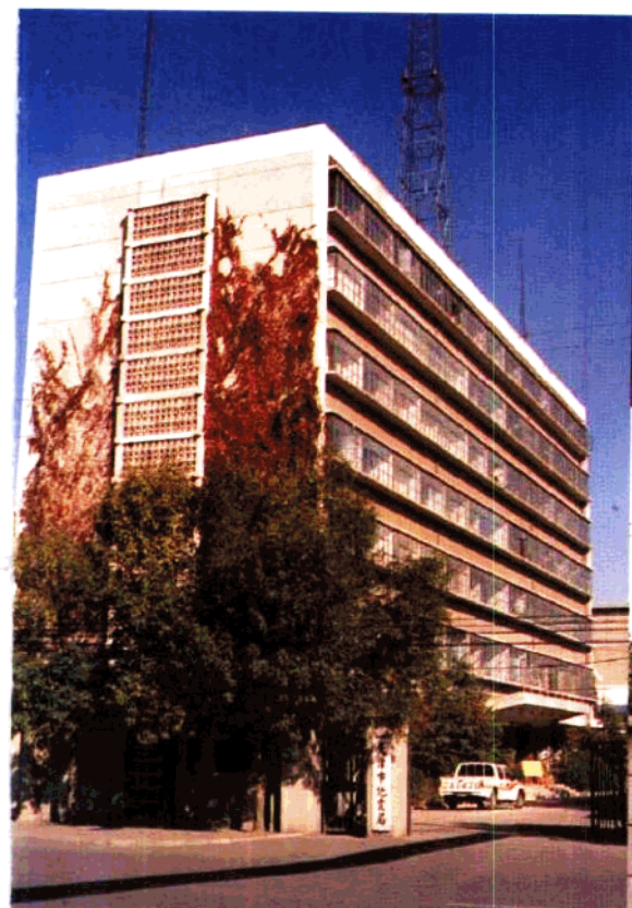
天津市地震局办公楼
