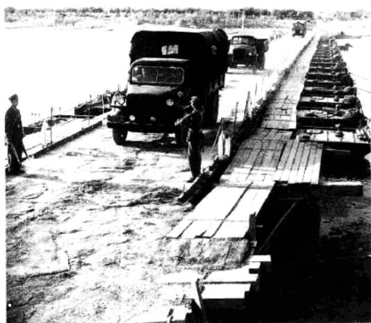
1976年7月28日地震，宁河蓟运河大桥震毁，人 民解放军舟桥部队及时架起舟桥，保证运输畅通
